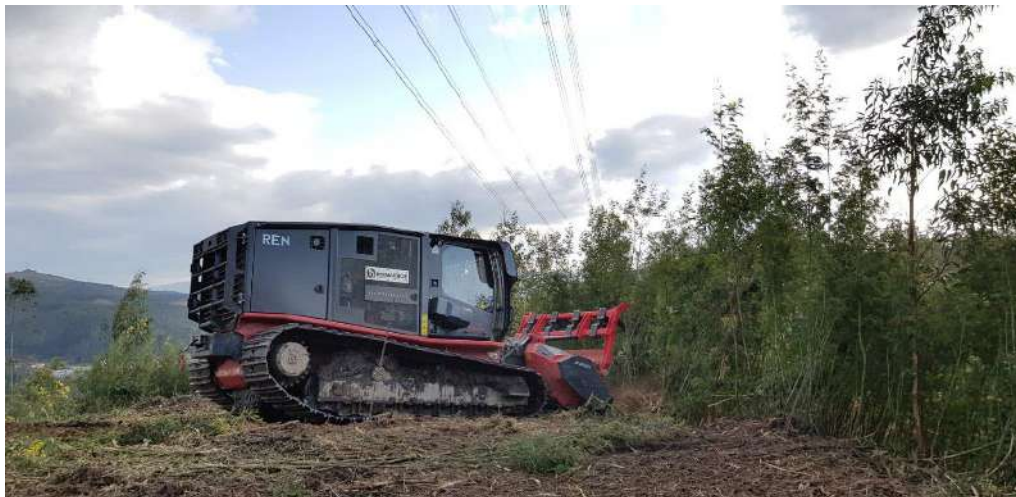
Figura 2: Destroçador florestal automotriz em operação na rede da REN.
