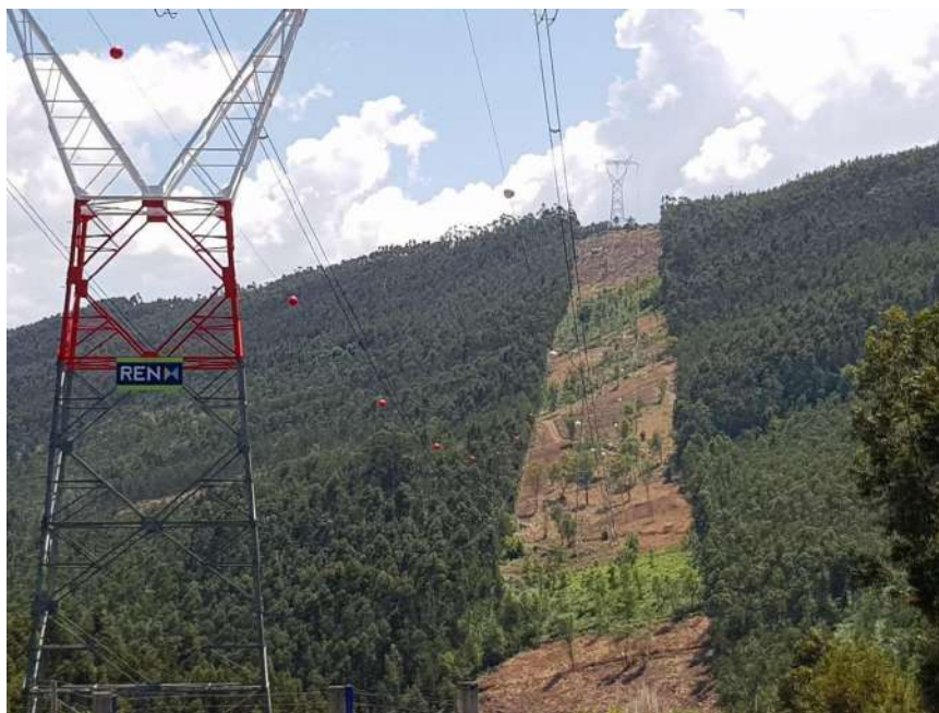
Figura 1: Faixa de gestão de combustível sobre a rede da REN.
